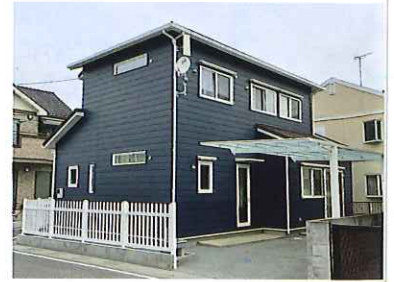
リノベ後の外観。外張り断熱を施した上で金属サイディングで仕上げている
