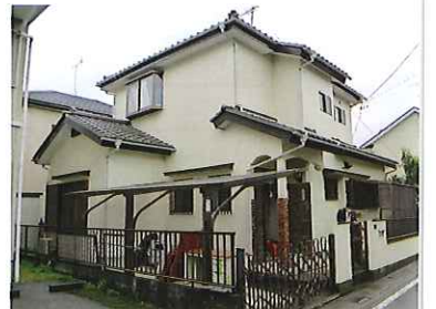
既存の外観。外壁などの維持管理はきちんとなされていた
