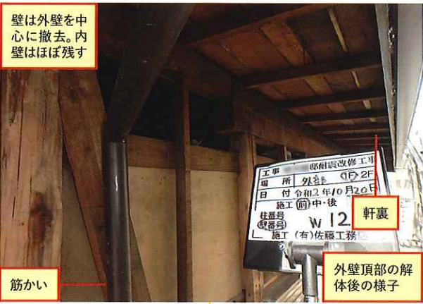
ムクの野地板は雨漏りしていなければ数十年経過しても健全な状態
