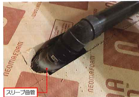
地中からの配管は将来交換できるようにスリーブ曲管を使用
