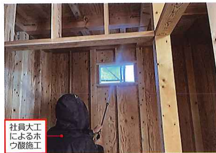
躯体全体にホウ酸処理をする。メーカーの講習を受けた大工が施工する
