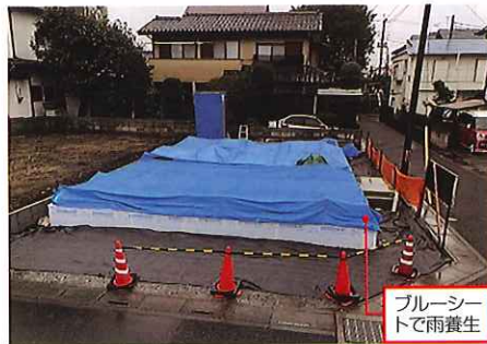
打ちあがった基礎は建て方まで雨に降られて濡れないようにブルーシートで養生する
