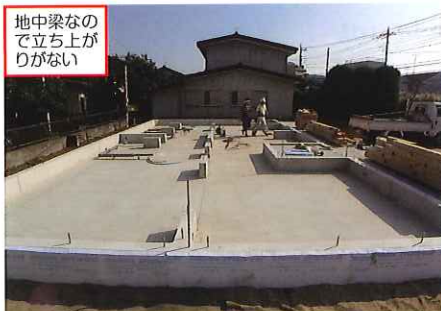
打ちあがった基礎の状態。パッシブ換気と床下エアコンを機能させるために地中梁にして立ち上がりを省略している
