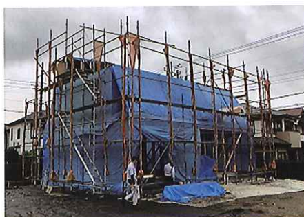
上棟後は雨養生をして躯体を濡らさないようにして初期結露を防ぐ
