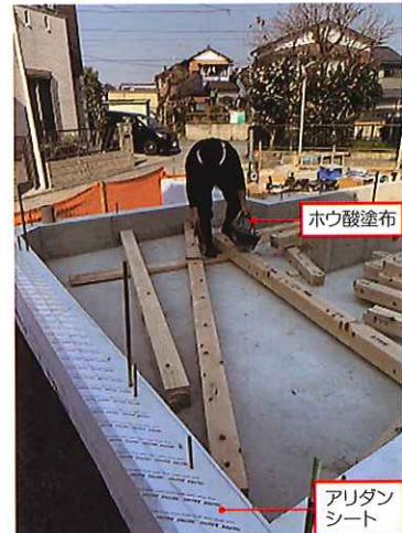
土台にホウ酸を塗る大工。白アリ対策は念入りに行う。基礎の天端には防蟻剤を練り込んだシートを敷き込む
