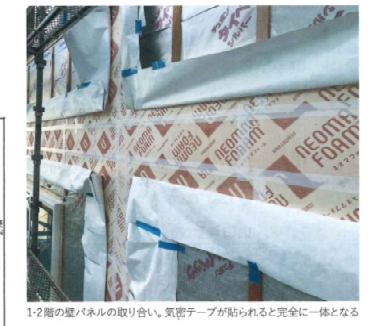
1-2階の壁パネルの取り合い。気密テープが貼られると完全に一体となる
